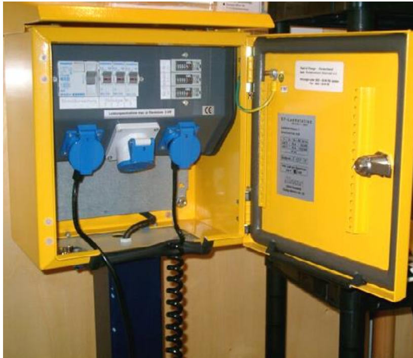
Abbildung 7-6: Ladesäule der AG Park & Charge des Bundesverbands Solare Mobilität
