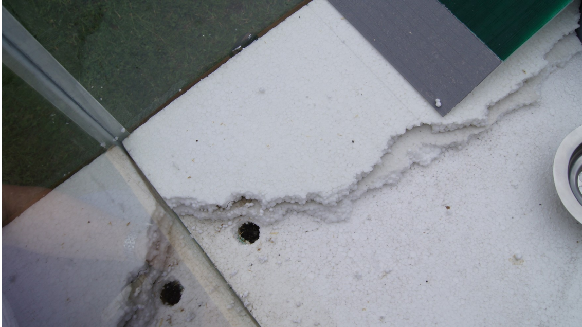
Abbildung 36: Bohrung für den Wasserzulauf (C. Weise)
