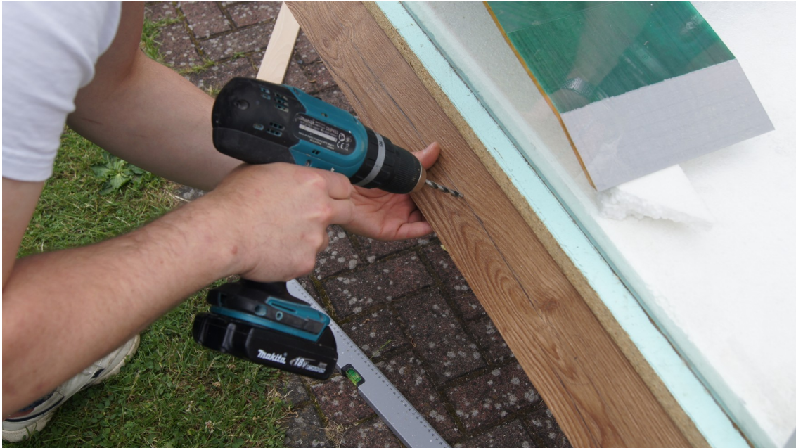
Abbildung 40: Bohrungen im Bedienfeld (H. Petschull)
