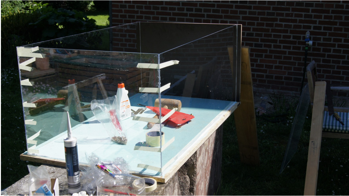
Abbildung 32: Mit Klebeband versehene Ecken (C. Weise)
