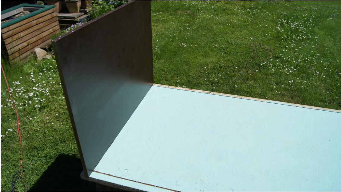
Abbildung 26: Eingesetzt Rückwand auf der Grundplatte (C. Weise)
