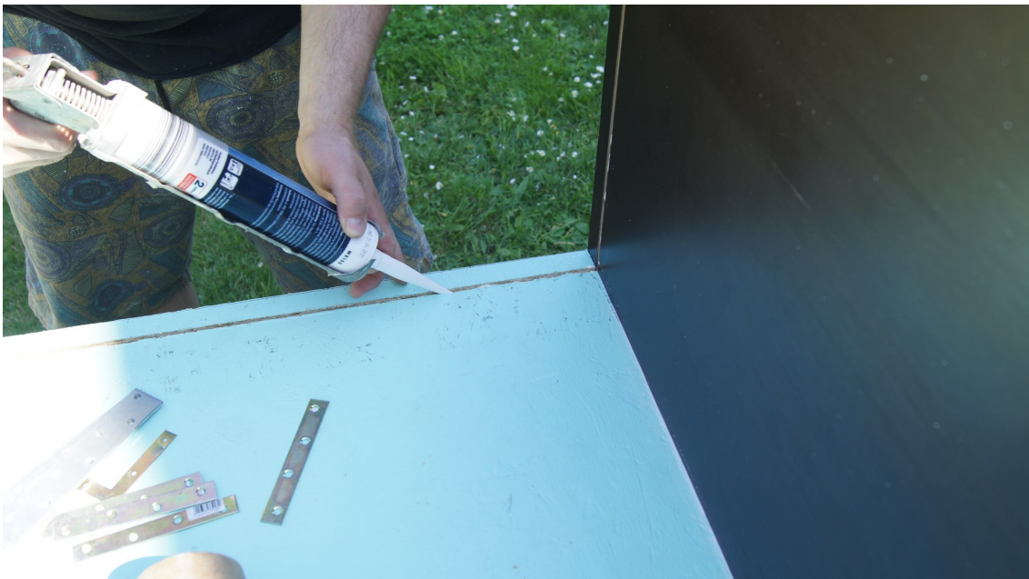
Abbildung 31: Eintagen des Montageklebers in die Nuten (C. Weise)
