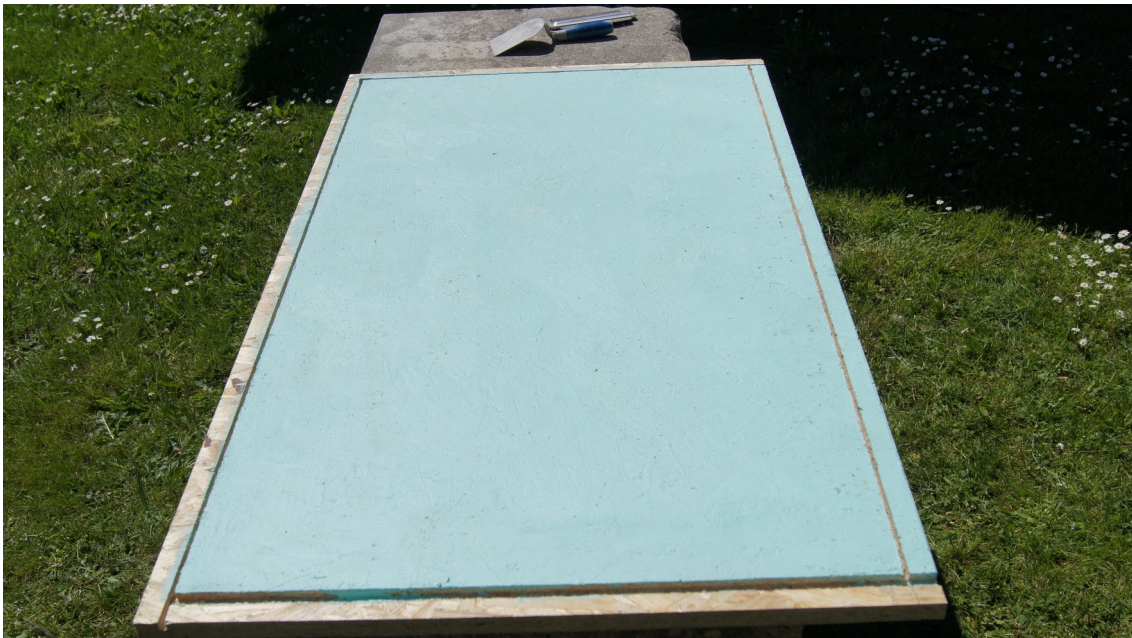
Abbildung 25: Mit Abdichtfarbe eingestrichene Grundplatte (C. Weise)
