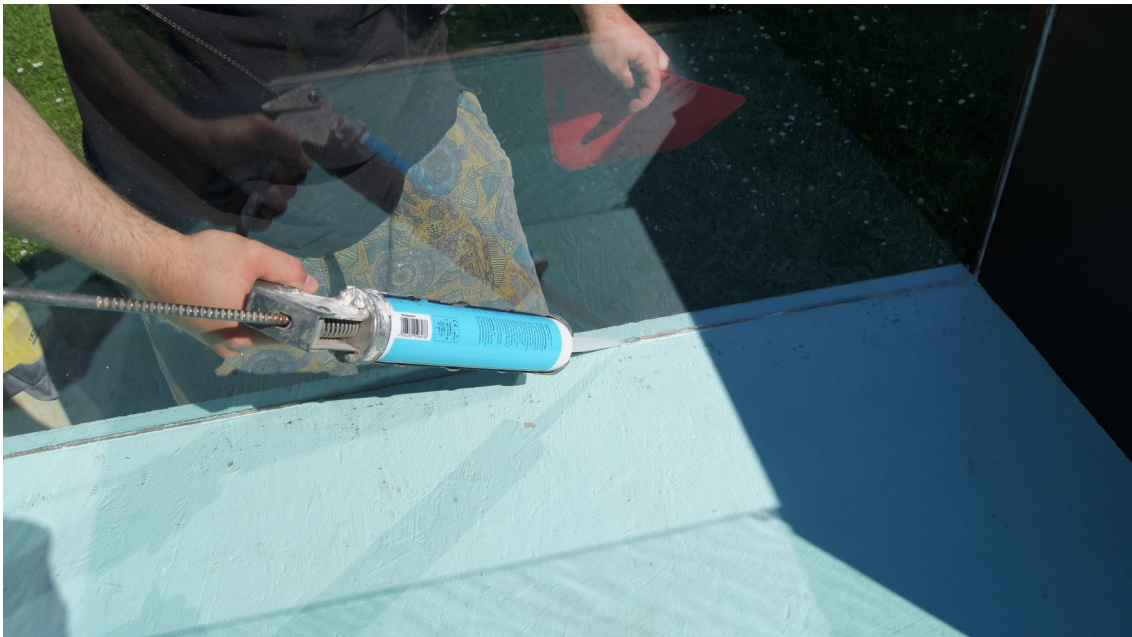
Abbildung 33: Einbringen der Silikonfugen (C. Weise)
