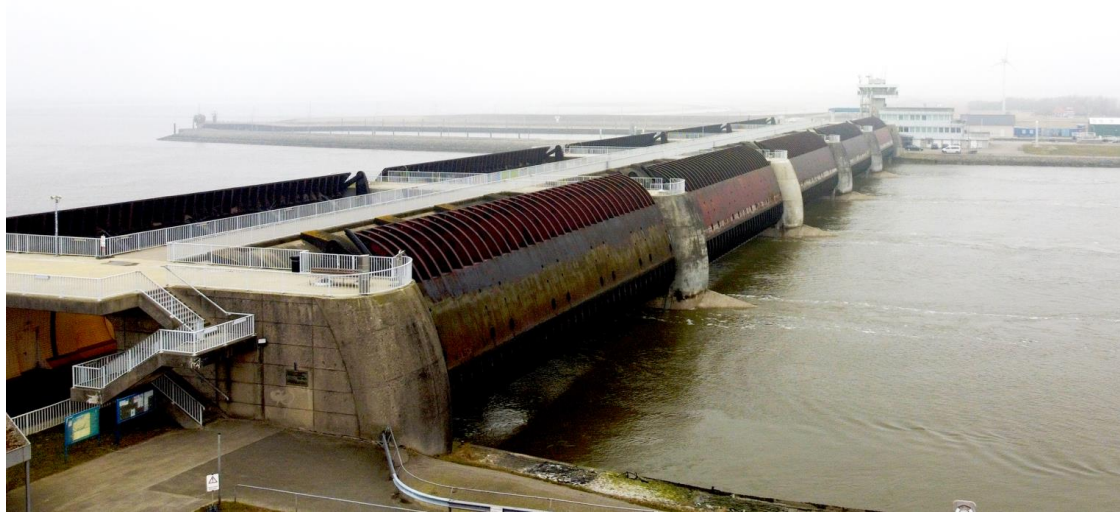
Abbildung 1: Eidersperrwerk bei Tönning (Foto: C. Weise)
