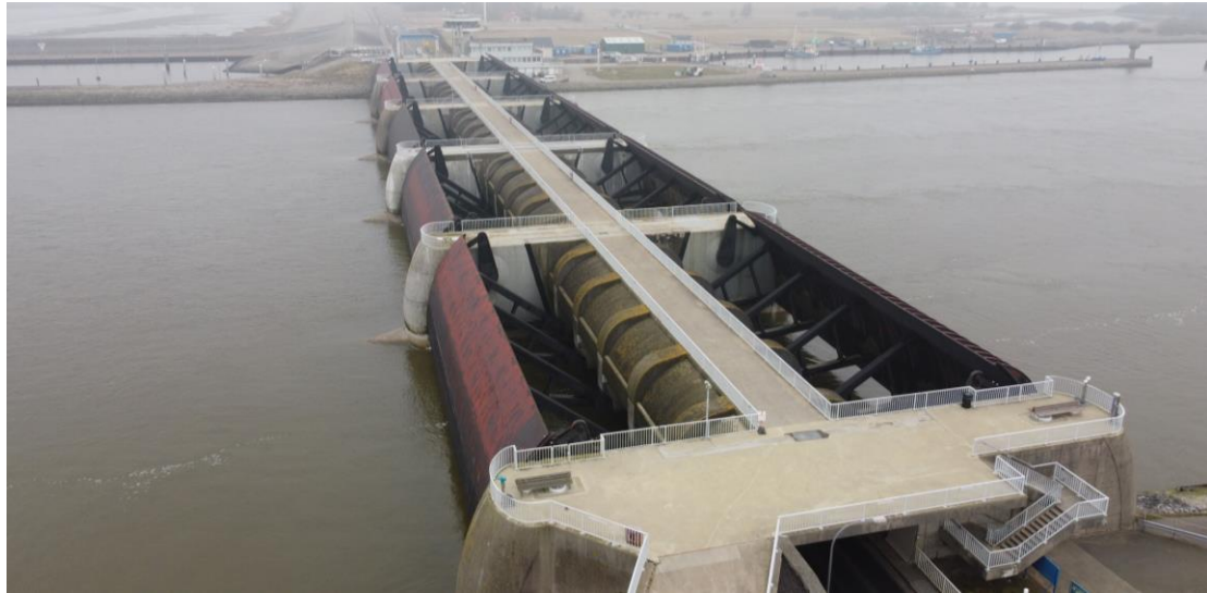
Abbildung 14: Außenmauer des Eidersperrwerkes (Foto: C. Weise)
