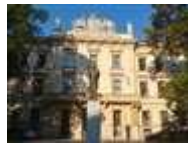
Das Hauptgebäude der Uni
