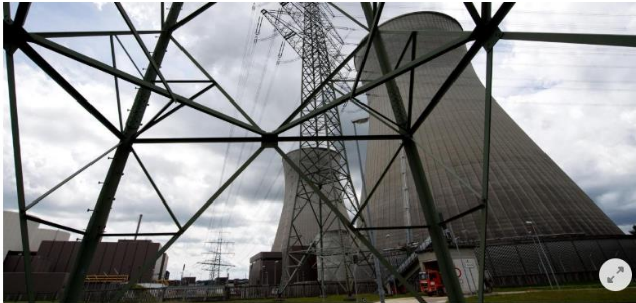
Nur noch zur Hälfte in Betrieb: das Atomkraftwerk Gundremmingen bei Günzburg (Bayern)
