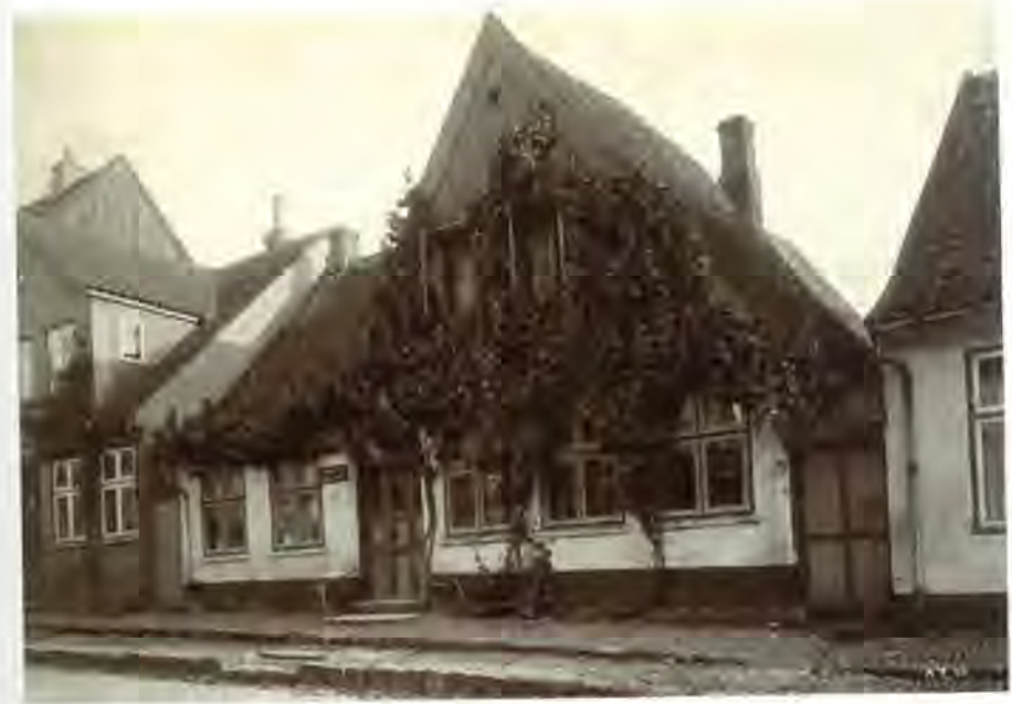
Abb. 2 Vorderhaus der Adresse Domziegelhof 8 um 1910. Rechts ist der Durchgang zum Hinterhaus erkennbar
